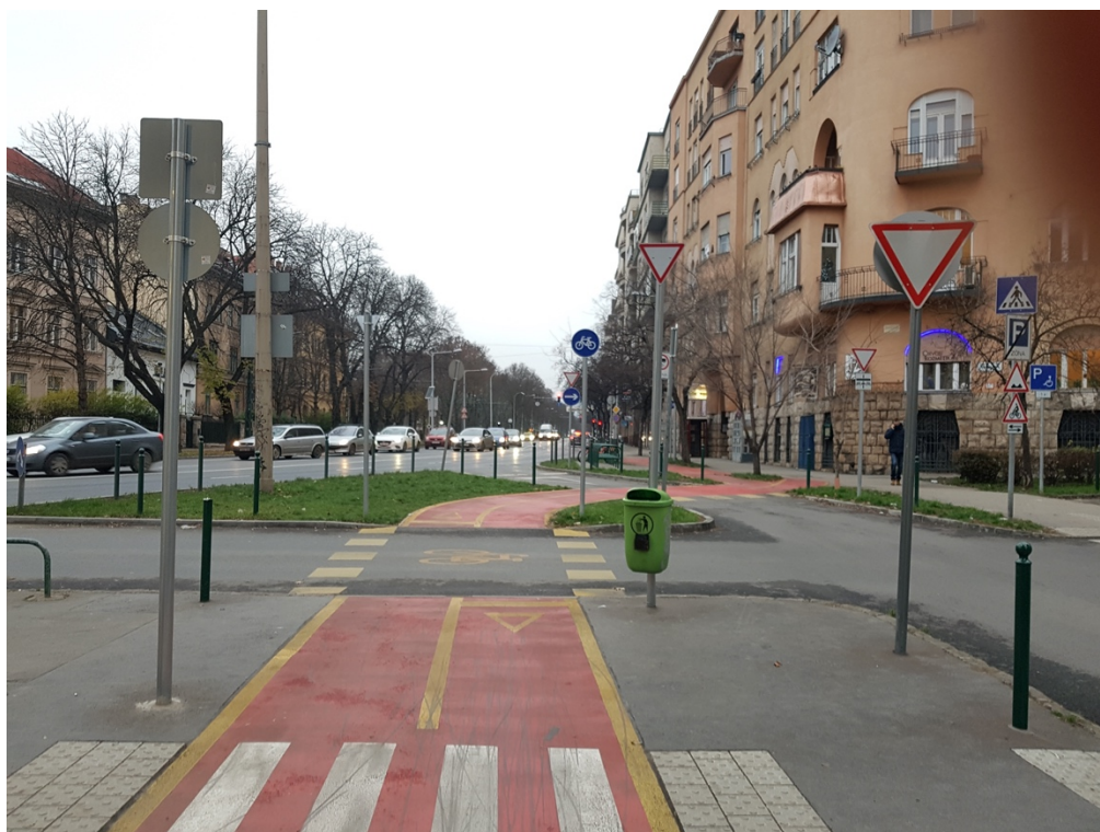
1. kép. A Retek utca – Káplár utca – Szilágyi Erzsébet fasor kereszteződés. Elöl a Káplár utcánál a biciklistáknak kell elsőbbséget adniuk; hátul a Retek utcánál övük az elsőbbség.
