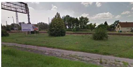
3. kép Ferihegyi repülőtérre vezető úti kerékpárút leromlott szakasza
