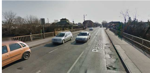
19. kép „Kőhíd” mellett létesítendő kerékpáros híd
